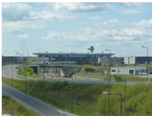
Auf der Baustelle, die von außen optisch fertig erscheint, erfolgten 2013 neben der Bestandsaufnahme der Mängel auch Bauarbeiten. Schwerpunkte waren der Ausbau der Erweiterungspavillons sowie die Weiterführung von Restarbeiten am Gesamtbauwerk, die Sanierung der Kabeltrassen und die Beseitigung von Baumängeln.
