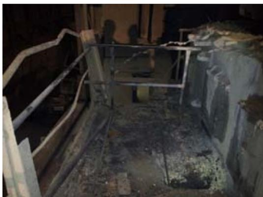
Mit der Arbeitsaufnahme waren unter anderem die stündlichen Verfüllarbeiten manuell aufgenommen worden. Während einer routinemäßigen Arbeit stürzte der Mitarbeiter des Schmelzbetriebes durch die ungesicherte Bodenöffnung 10 m in die Tiefe und zog sich Becken- und Rippenbrüche, Muskelabrisse und Prellungen zu.
