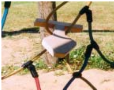
Abbildung 6: Seilklettergerät mit gefährlicher Schlaufe für den Kopf
