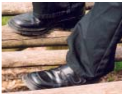
Abbildung 7: Brücke mit zu großen Zwischenräumen in der Beplankung
