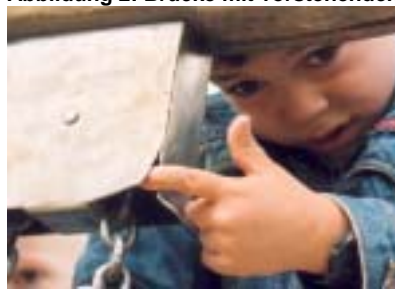
Abbildung 4: Kettenrollaufhängung mit verbogener Abdeckung
