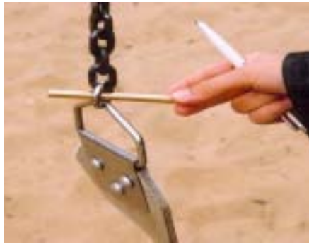
Abbildung 5: Kette an Schaukel mit zu großem Verbindungsring
