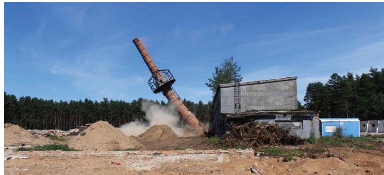
▶ Abbildung 4: Schornsteinsprengung in der Uckermark
