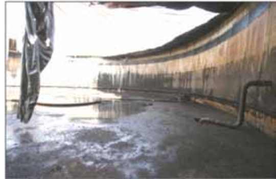
Abbildung 7: Der Innenraum des Behälters
