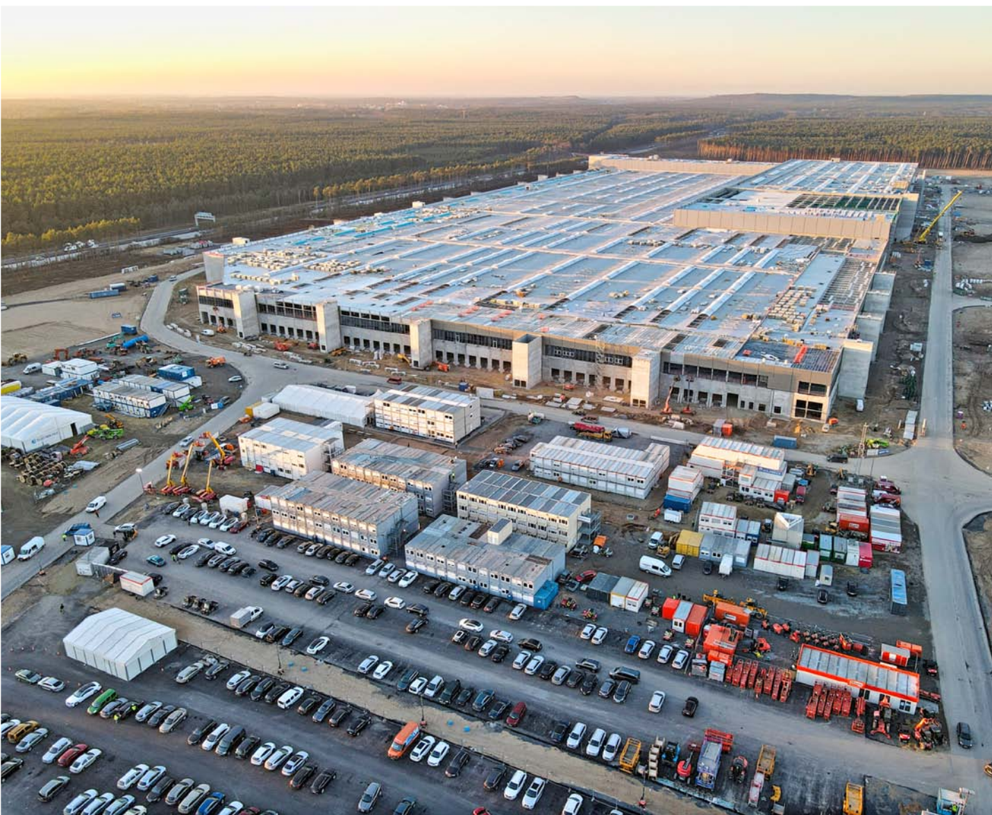
Luftbildansicht der TESLA Gigafactory Brandenburg aus dem Jahr 2021, Tesla Gigafactory, © Christian – stock.adobe.com
