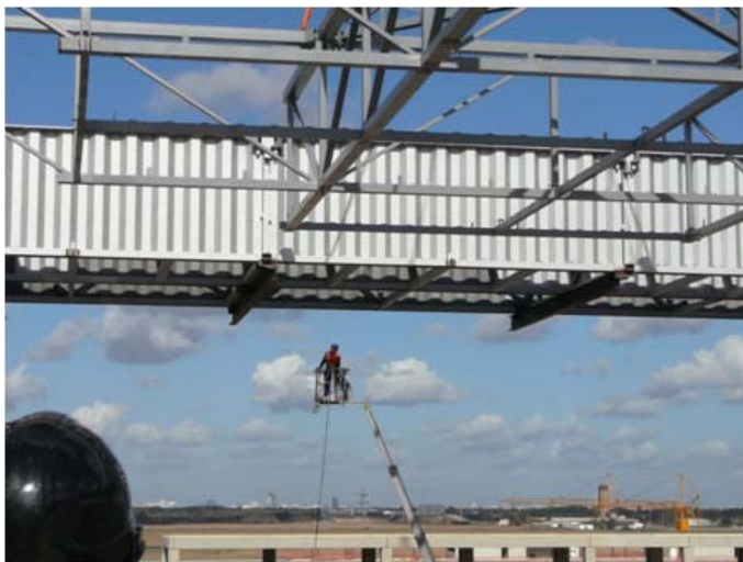
Abbildung 3: Ein Stahlbauteil für das Terminaldach
