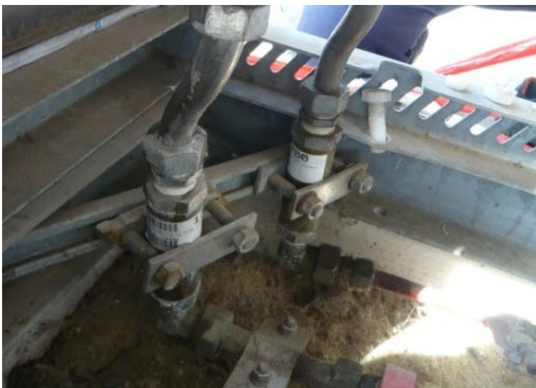
Abb. 14: Rohrbruchsicherung kraftschlüssig
