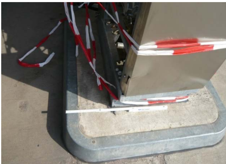
Abb. 13: Versatz LPG-Zapfsäule
