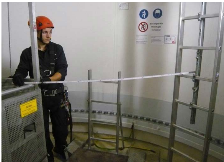
Abb. 9: Abstand Fahrkorb / Steigleiter
