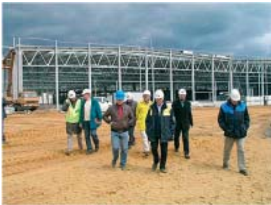
Abbildung 21: Gemeinsamer Baustellenbesuch in Waldau/ Wykroty
