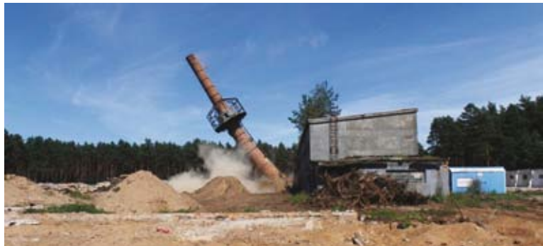
▶ Abbildung 4: Schornsteinsprengung in der Uckermark
