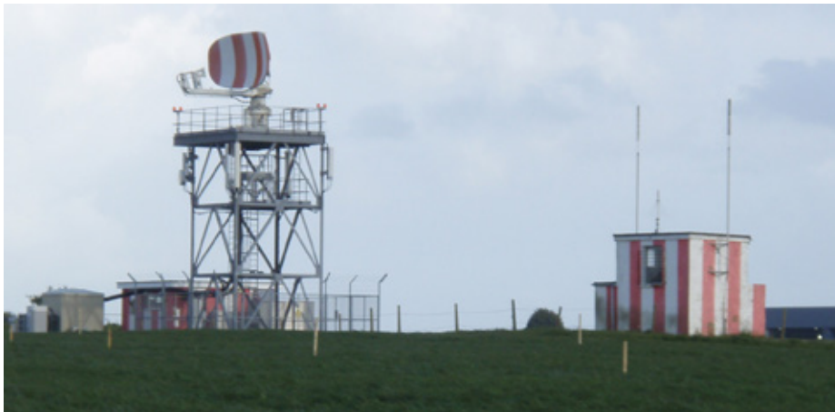
Abbildung 12.1 – Beispiel für die Rundstrahlradaranlage eines Flughafens
