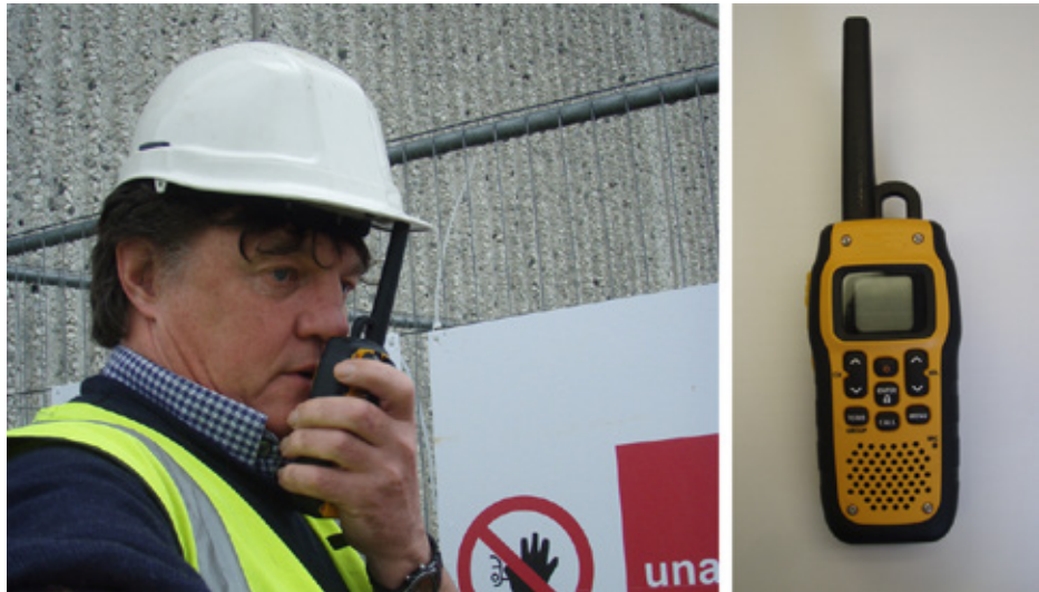
Abbildung 11.1 – Arbeitnehmer auf der Baustelle mit Walkie-Talkie
