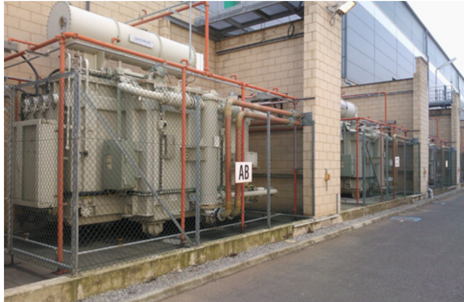
Abbildung 3.4 – Die Transformatorenbuchten
