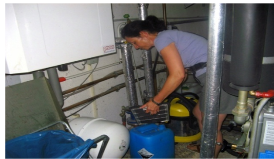
Abb. 4 und 5: Ausbau und Reinigung des Flusensiebes
