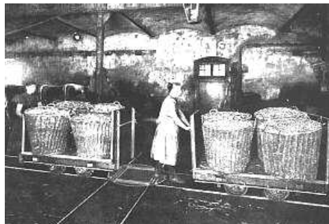
Abb. 17 Manueller, spurgeführter Transport von Kartoffeln und Möhren in einem Lagerraum
