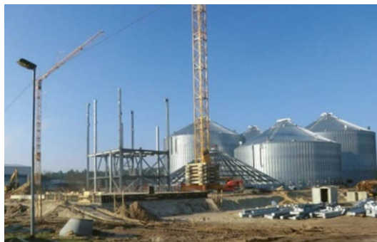
Abbildung 24: Absturzstelle von unten
