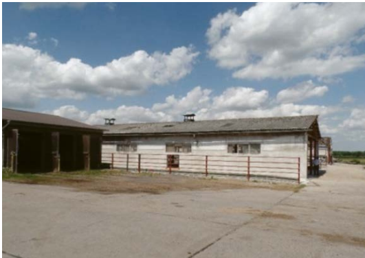
Abbildung 29: Stall mit Wellasbestdach
