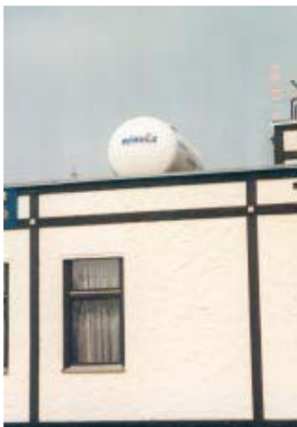
Abbildungen 9 und 10: Aufstellung des Flüssiggaslagerbehälters auf einem Dach
