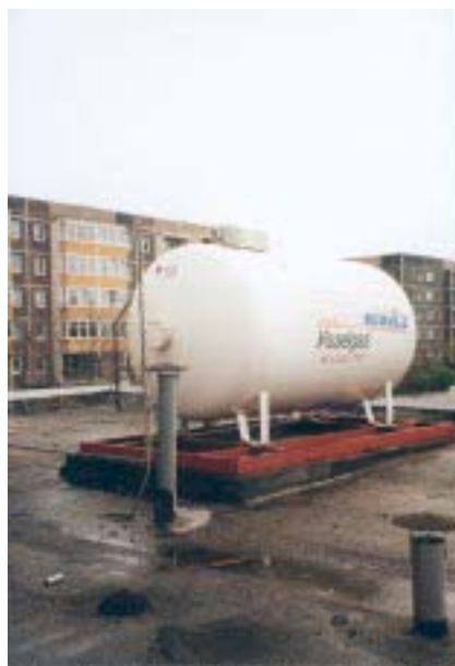
Abbildungen 9 und 10: Aufstellung des Flüssiggaslagerbehälters auf einem Dach
