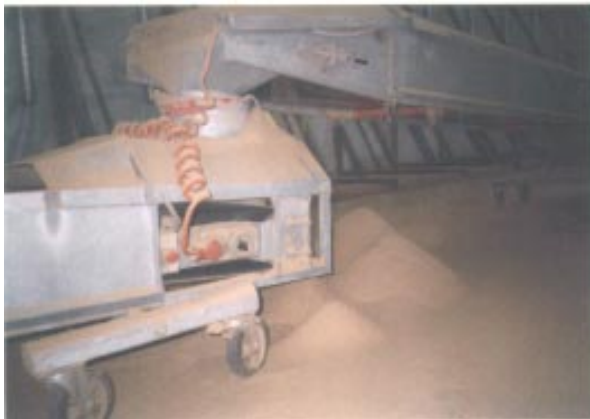
Abbildung 9: Staubablagerungen durch undichte Förderanlagen
