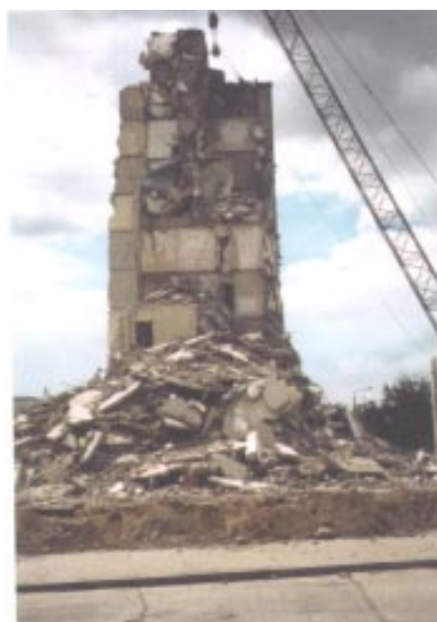
Abbildungen 23 und 24: Der Einsatz der Bagger in den verschiedenen Rückbauphasen
