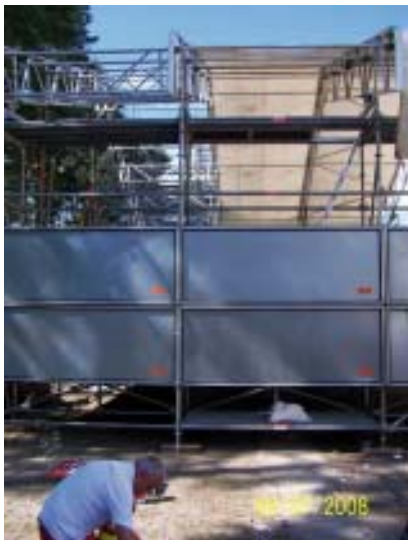
Abbildung 36: eine Teilansicht der Kederhalle
