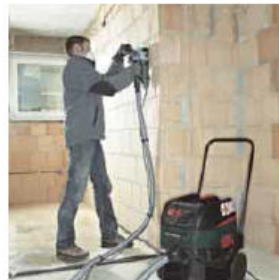
Bild 1 und 2: Beispiele für abgestimmte Systeme: Mauermutfräse und Winkeltrennschleifer mit Umbausatz für Mauermutfräse mit einem Entstauber der Staubklasse M
