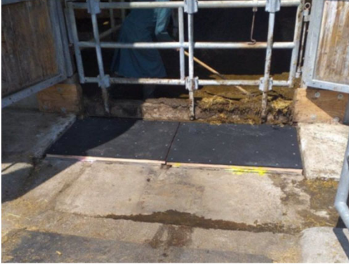
Gülleabwurfgitter-Abdeckung: Holzplatte mit Streben, die in die Spalten des Gitters greifen, um ein Rutschen zu verhindern. Aufgenagelte Gummimatten.
